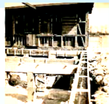
Clubhaus 1951 vor der Renovierung
